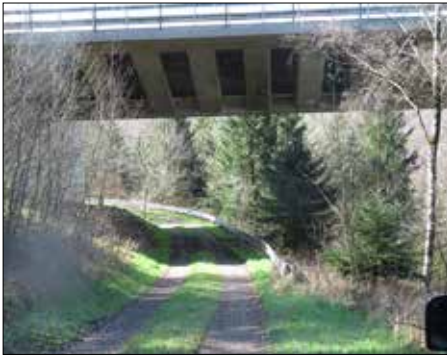
Abbildung 24: Beobachtungsplatz unter der Löstertalbrücke, Foto: M. Geib
