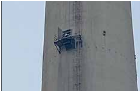
Abbildung 16: Abbrucharbeiten am Kasten, Foto: KW Ens Dorf
