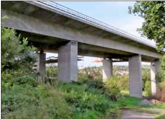
Abbildung 7: Henschbachtalbrücke der A62, Foto: M. Geib
