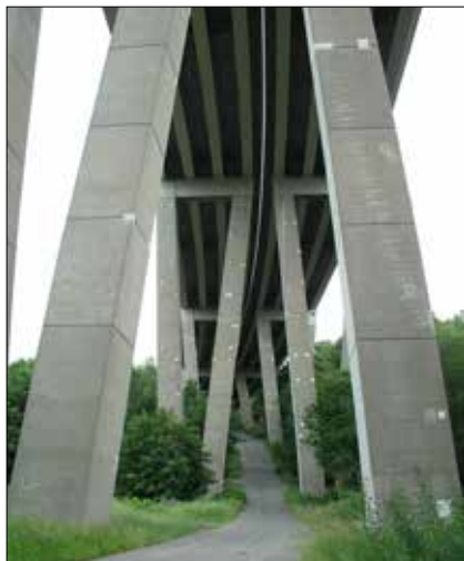
Abbildung 38: Das Revier unter der Sulzbachtalbrücke, Foto: M. Geib
