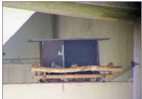
Abbildung 26: Weib im Kasten der Primstalbrücke, Foto: M. Geib
