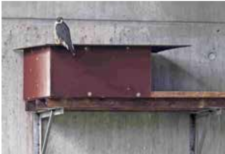
Abbildung 9: Wanderfalke an der Henschbachtalbrücke, Foto: Dr. E. Segatz
